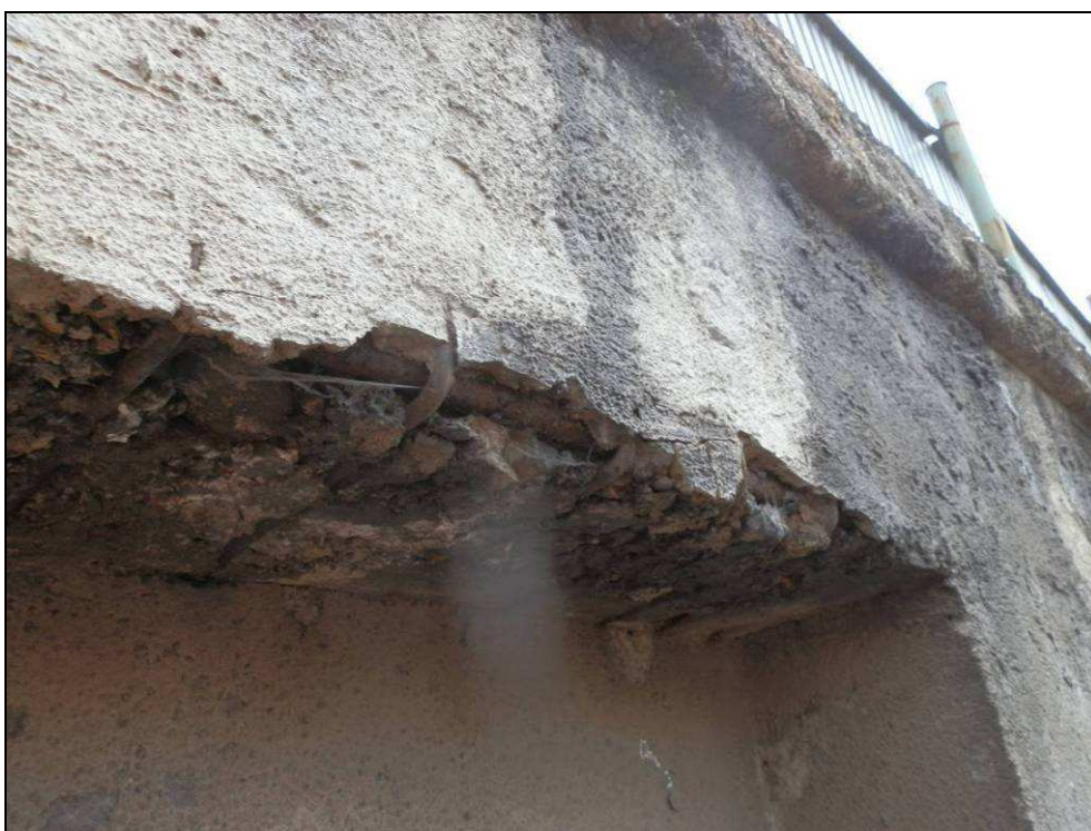
Obr. č. 12 - 3. část OZ km 40,987 - 40,994, detailní pohled na beton římsy s obnaženou tahovou výztuží.
