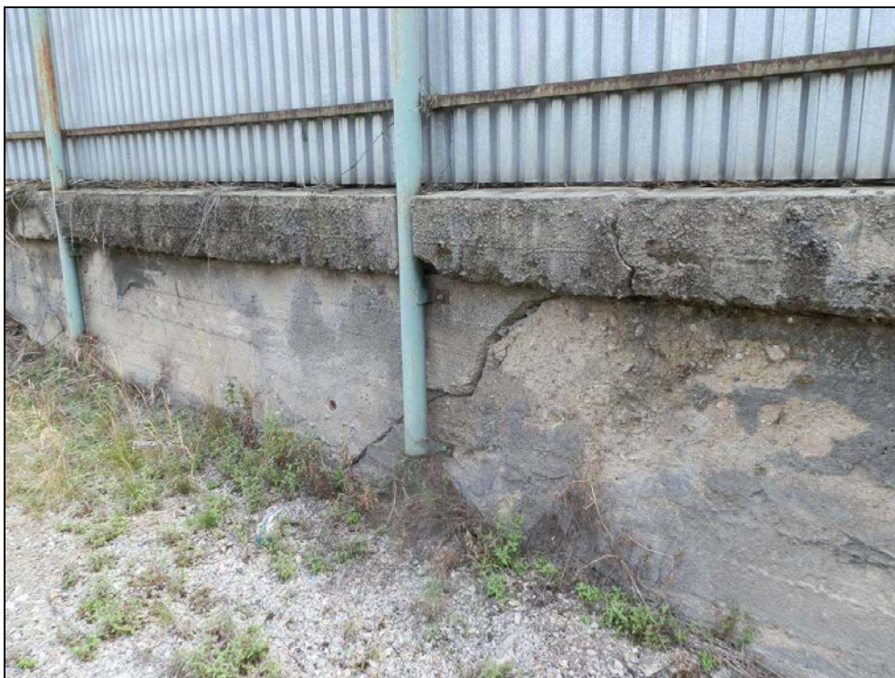
Obr. č. 4 - pracovní spára jdoucí přes dřík a římsu, spárou prosakuje voda a v jejím okolí se urychlují degradační procesy koroze betonu, který opadává do hloubky 30 až 40 mm
