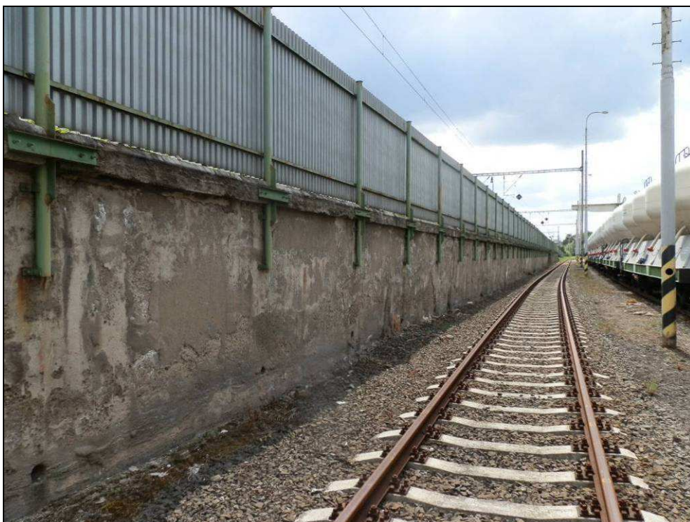
Obr. č. 8 - 2. část OZ km 40,870 - 40,987, pohled na střed úseku ve směru Plzeň. Povrch betonu je porušený, místy prosakuje voda, u paty zdi jsou opadané fragmenty betonu.
