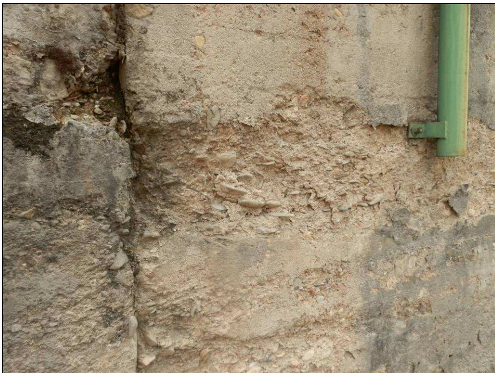
Obr. č. 15 - 4. část OZ km 40,994 - 41,134, detailní pohled na porušený povrch betonu. Částý je zde tzv. vytříděný beton, dále jsou četné oblasti s celkově nízkým obsahem pojiva. Spárami mezi částmi prosakuje voda.
