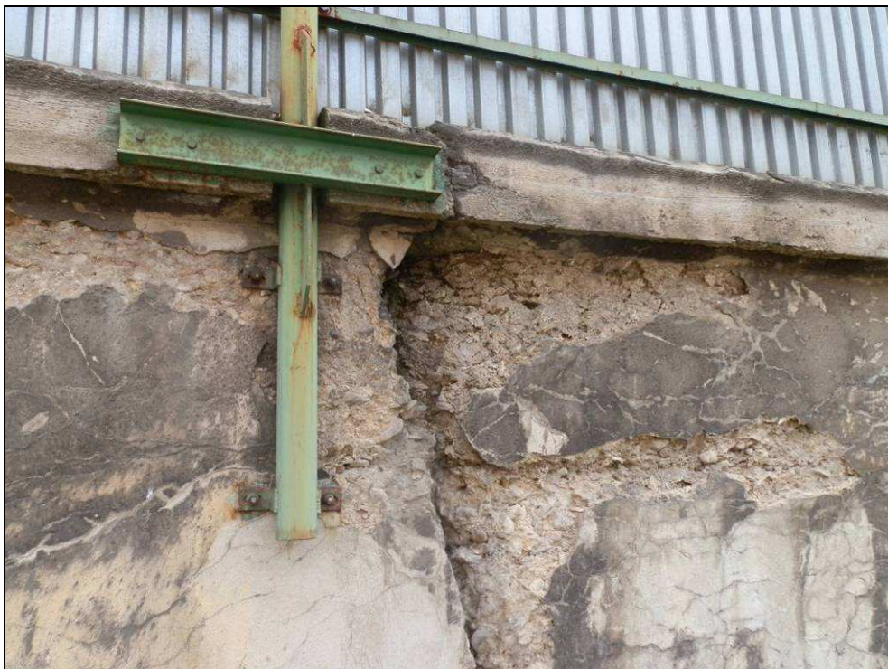
Obr. č. 17 - 4. část OZ km 40,994 - 41,134, detailní pohled na porušený povrch betonu, římsu a pracovní (?) spáru.
