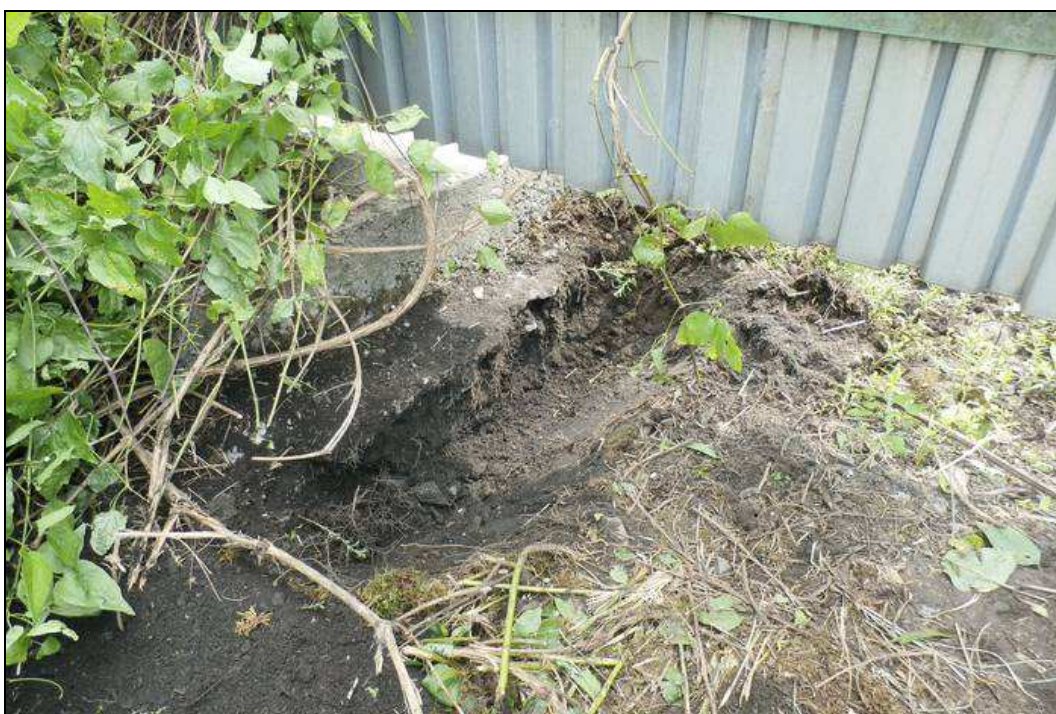
Obr. č. 20 - KS11 pro ověření existence opěrné zdi v km 40,680 - detailní pohled na kopanou sondu u patky sloupku oplocení
