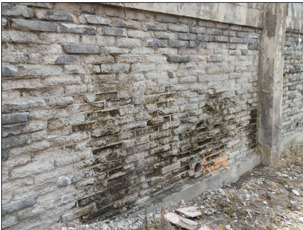
Obr. č. 5 - 1. část OZ km 40,625 - 40,870, detailní pohled na porušené lícové zdivo v km cca 40,842 z betonových cihel. Zde prosakuje lícem voda.
