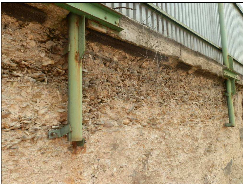
Obr. č. 16 - 4. část OZ km 40,994 - 41,134, detailní pohled na porušený povrch betonu a římsu. Rozsáhlá oblast s vytříděným betonem. Mezi kameny jsou četné několikamilimetrové mezery. Hloubka opadání zde dosahuje běžně 50 mm, v maximu až 100 mm od původního líce.
